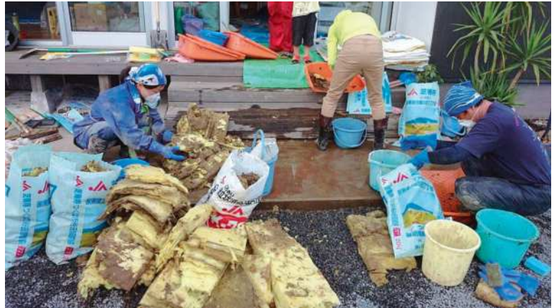
↑断熱材の取出し
