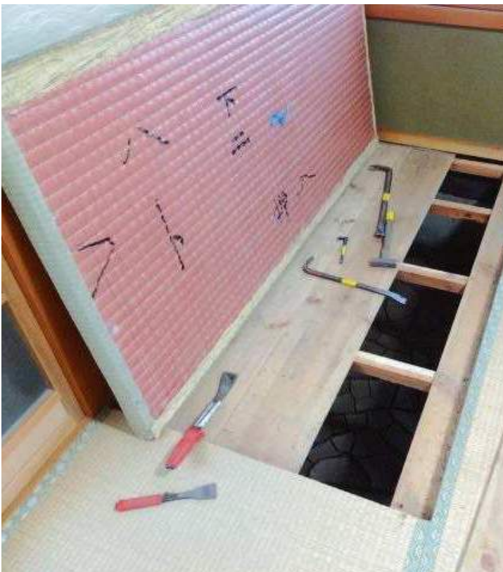
和室の床板をはがす（写真①）
